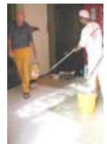
Нанесение Sikafloor Pronto 16 цвет. валиком
