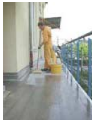
нанесение грунтовки
