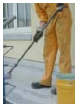
нанесение финишного слоя
