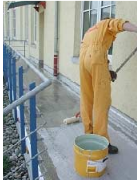
9:00 2-й этап грунтовка
