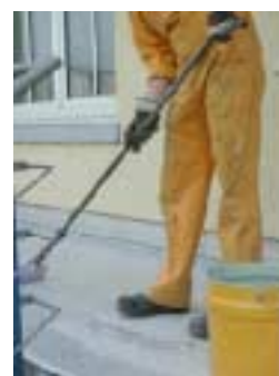
нанесение финишного слоя
