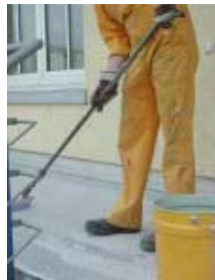
Нанесение Sikafloor 16 Pronto валиком
