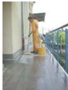
нанесение грунтовки
