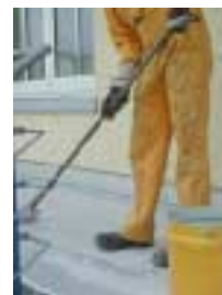
нанесение финишного слоя Sikafloor 16 Pronto transparent
