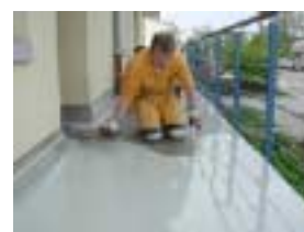
нанесение Sikafloor 14 Pronto
