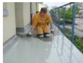
Нанесение Sikafloor 14 Pronto SL шпателем. SL – самовыравнивающаяся
