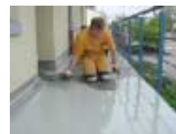
нанесение Sikafloor 14 Pronto SL
