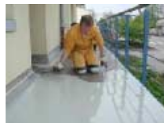
нанесение Sikafloor 14 Pronto
