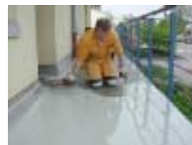
нанесение Sikafloor 14 Pronto
