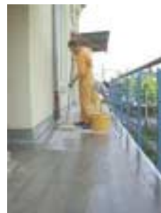
нанесение грунтовки
